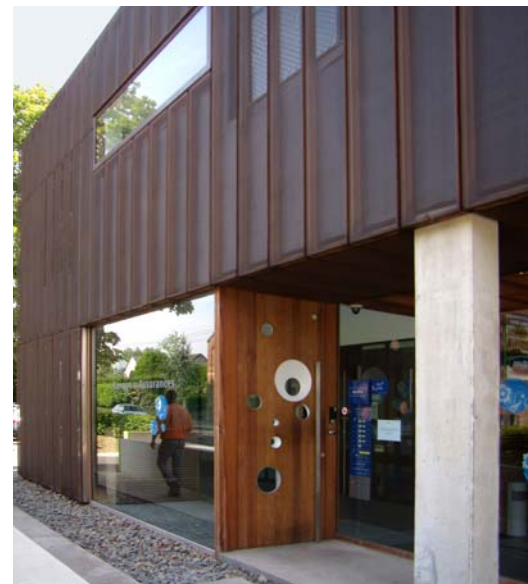
Zajímavý „nedřevěný“ materiál použitý na fasádní plášť – síť z tahokovu
