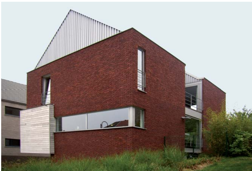
Režné zdivo z pálených tvarovek lze provést jako zavěšené, nebo jako v tomto případě jako představenou zeď z úzkých cihliček.
