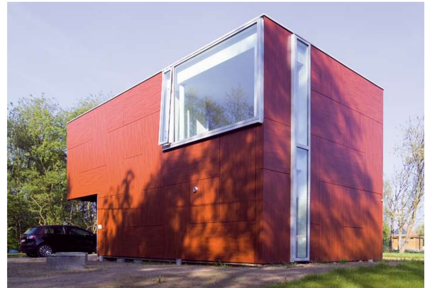
De gevel bestaat uit volkernpanelen.
